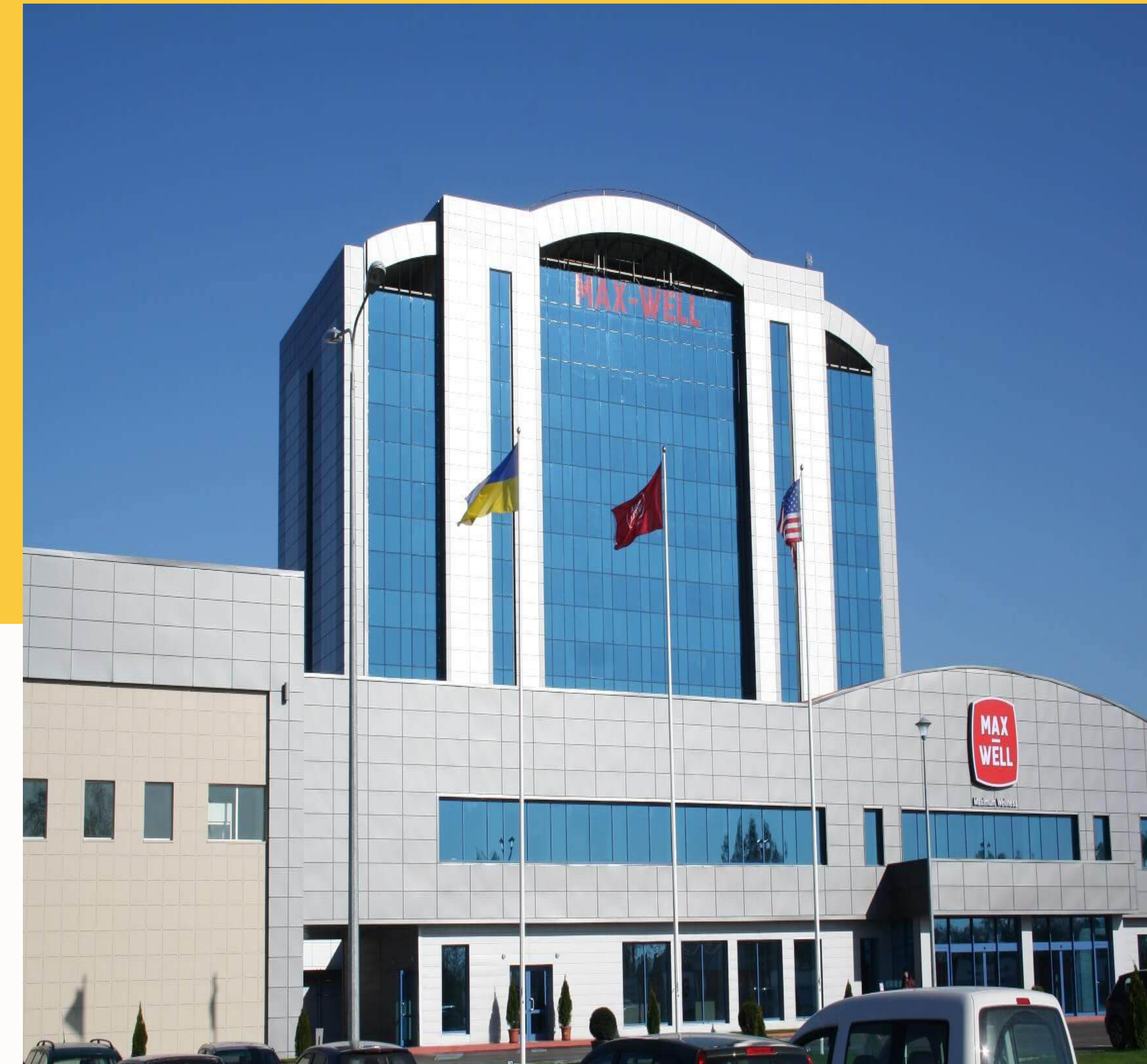
ФАРМАЦЕВТИЧНИЙ КОМПЛЕКС PHARMACEUTICAL COMPLEX
